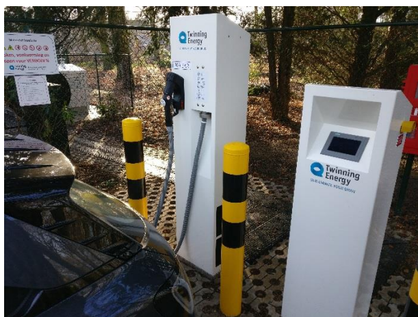
Figuur 1: Waterstofvulpunt bij het kantoor in Maarn. Gerealiseerd in samenwerking met Twinning Energy
